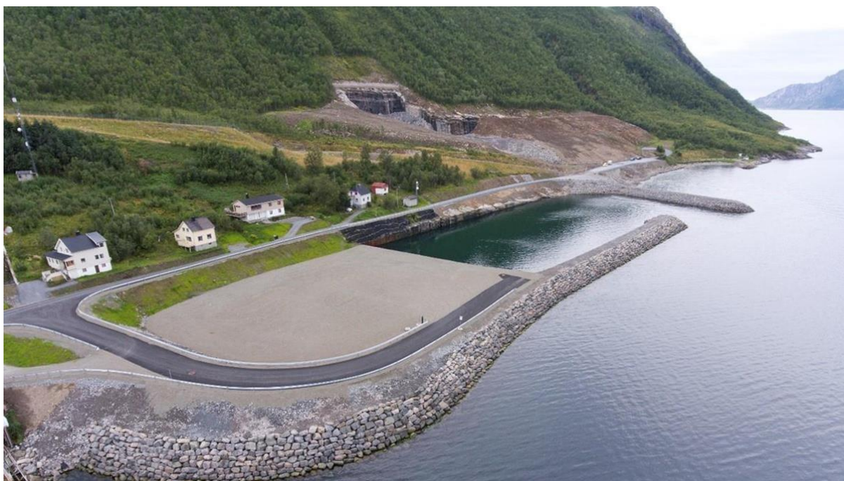
Fjordgård fiskerihavn, hvor moloer, utfylling av næringsområde og skredkanal er ferdigstilt. Kilde: www.senja.kommune.no
