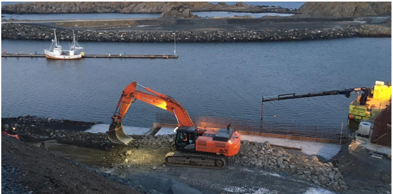
Bilde 5. Arbeid med nytt kaidekke på Hovden
