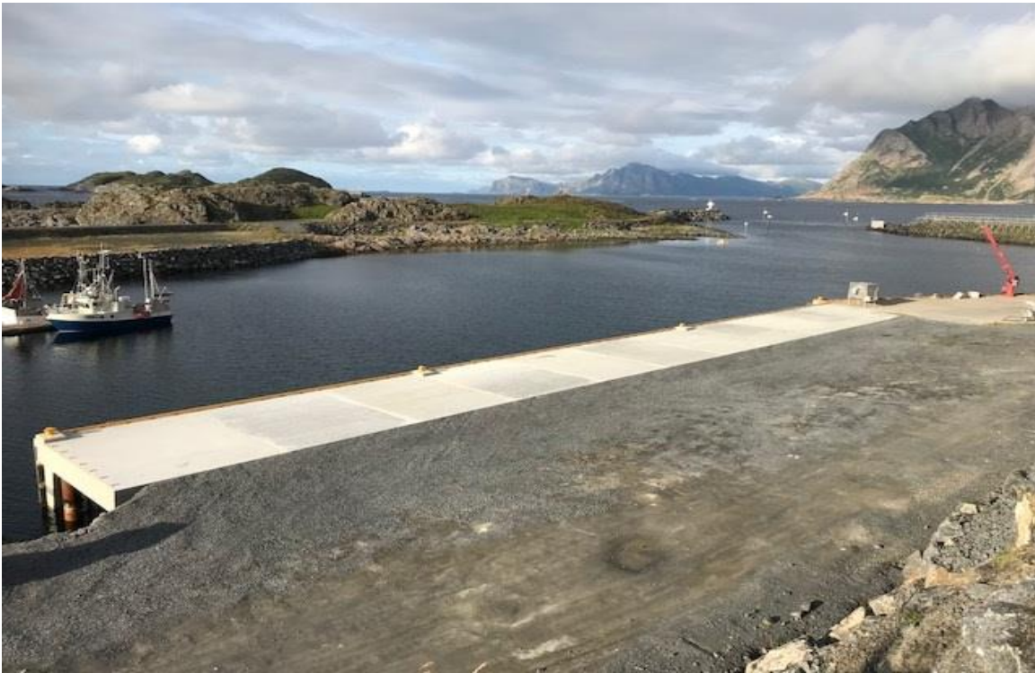
Bilde 6. Nytt kaidekke er ferdig
